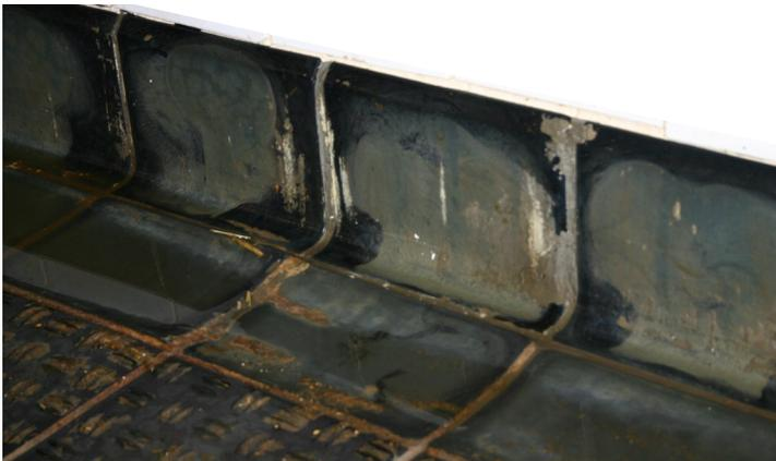
Detail der Anschlusslösung des Fußbodens an die Wand:
